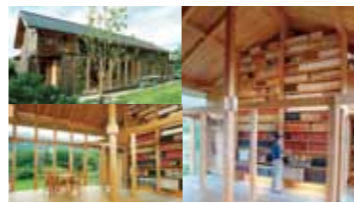
多材積木造建築ケース1: 柿林の家 (2005年) ●材積 1.55㎡/坪 木造2階建て 敷地面積532.48㎡ 建築面積155.50㎡ 延床面積184.15㎡
