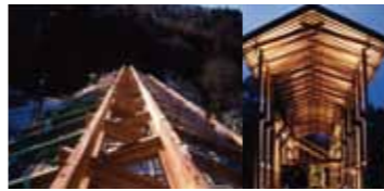
群馬県林業機械化センターの展示棟 (1996~2000年) ポルトを使わずすべて地元大工による木組み
